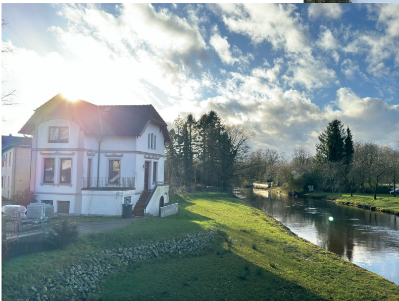
Ansicht von der Störbrücke / Friedrichstraße
